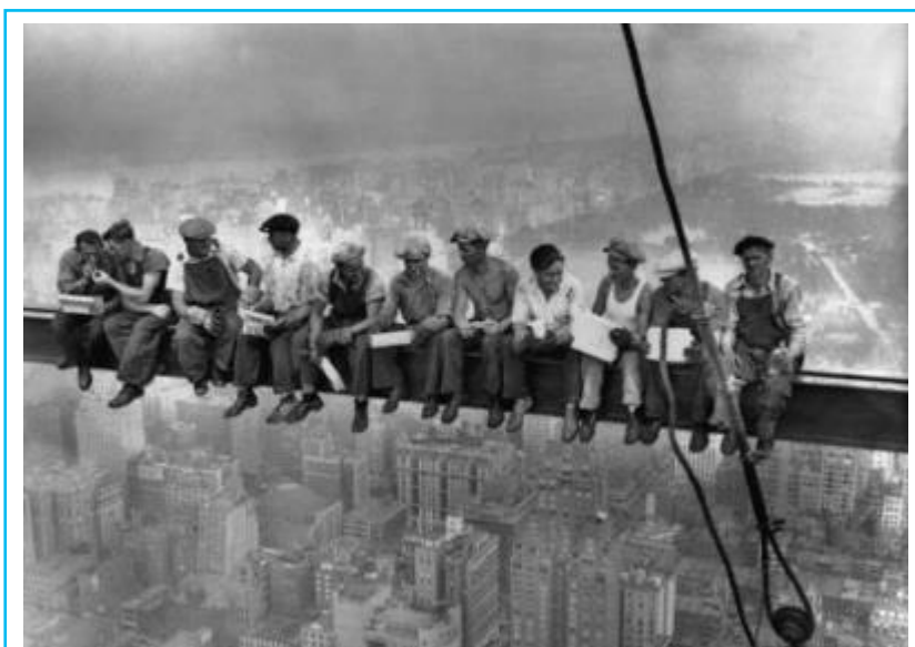
La imagen fue tomada desde el piso 69 del Rockefeller Center. Foto incógnita del día del trabajador. Almuerzo en lo alto de rascacielos obreros sentados sobre una viga en obra en construcción en el rockefeller center.
